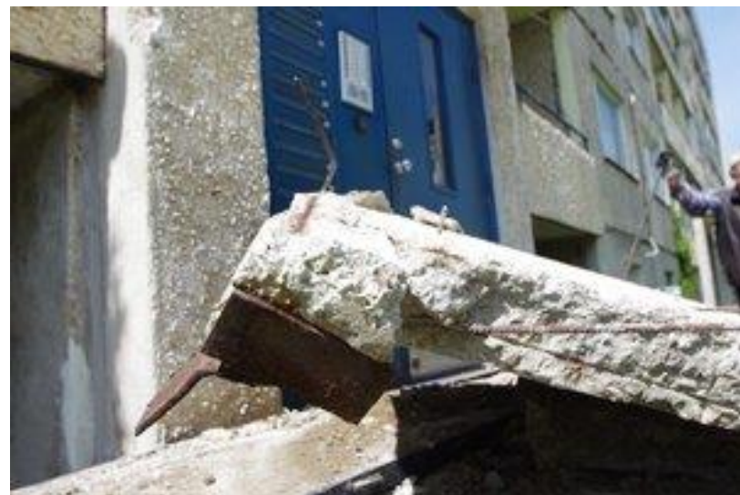
Keilas kukkus alla paneelhoone varikatus, juuni algus 2016
